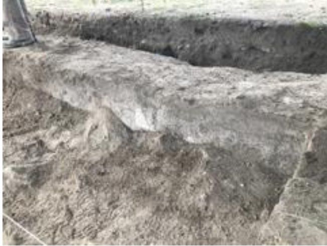
Figura 3.2. Muro del pórtico, con los primeros restos de pintura in situ. Nótese que los arqueólogos dejaron la capa de tierra como primera medida de protección.
