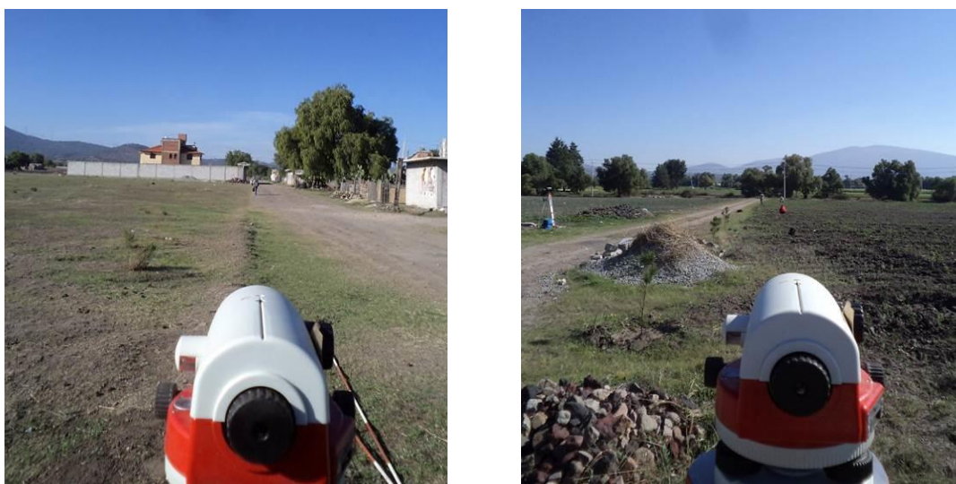
Figura 2.4. Establecimiento de los ejes principales para el trazado de las retículas.
